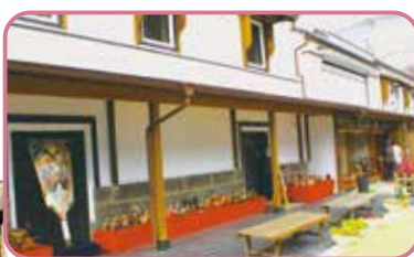
ひなの里の明治時代の蔵。埼玉県の「景観重要建造物」に指定されています。
