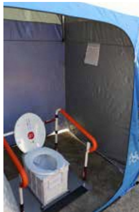
▲マンホールトイレ
