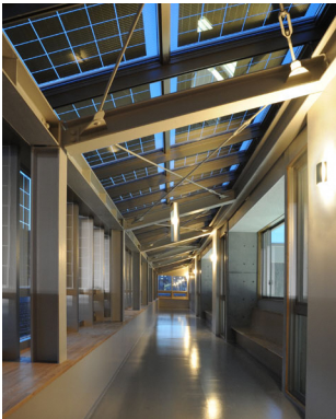
■太陽光発電パネル付通路
