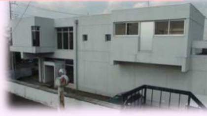
箕田浄水場 管理棟、配水池
