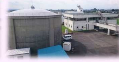
上写真：主な耐震診断・耐震補強の対象施設
