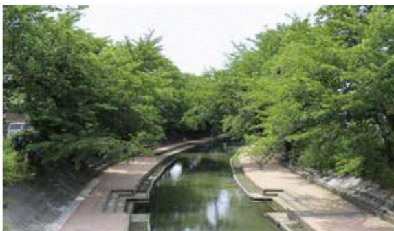
吹上元荒川親水護岸
