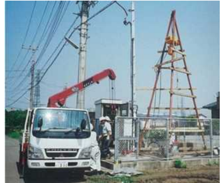
井戸の改修工事の実施状況
