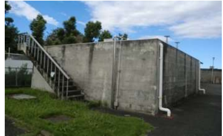
川里浄水場 配水池
