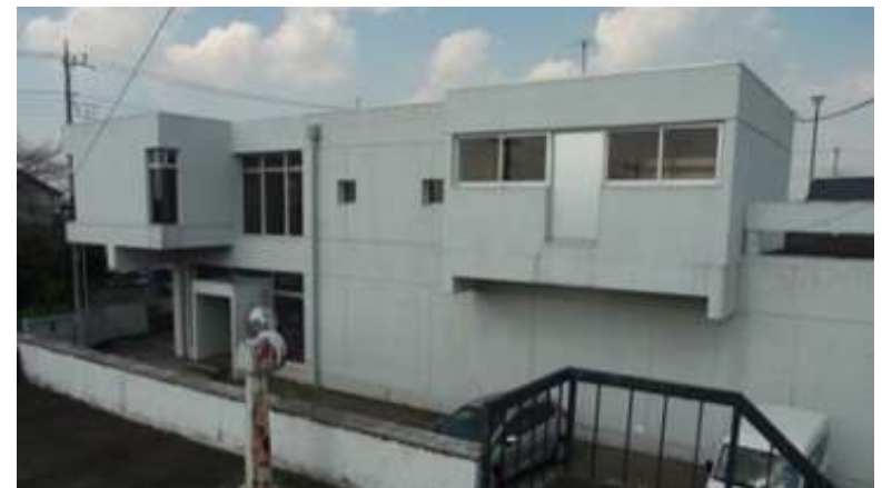
箕田浄水場 管理棟、配水池
