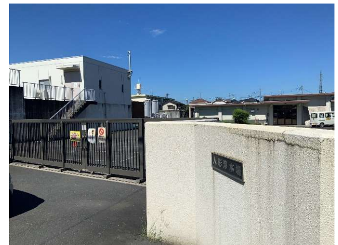
人形浄水場 着水井・混和池
