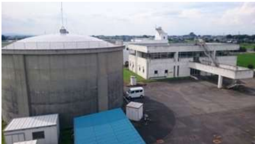
吹上第二浄水場 管理棟、配水池 【管路】
