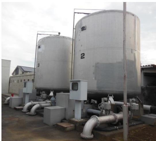
箕田浄水場 急速ろ過機 No.2, No.3
