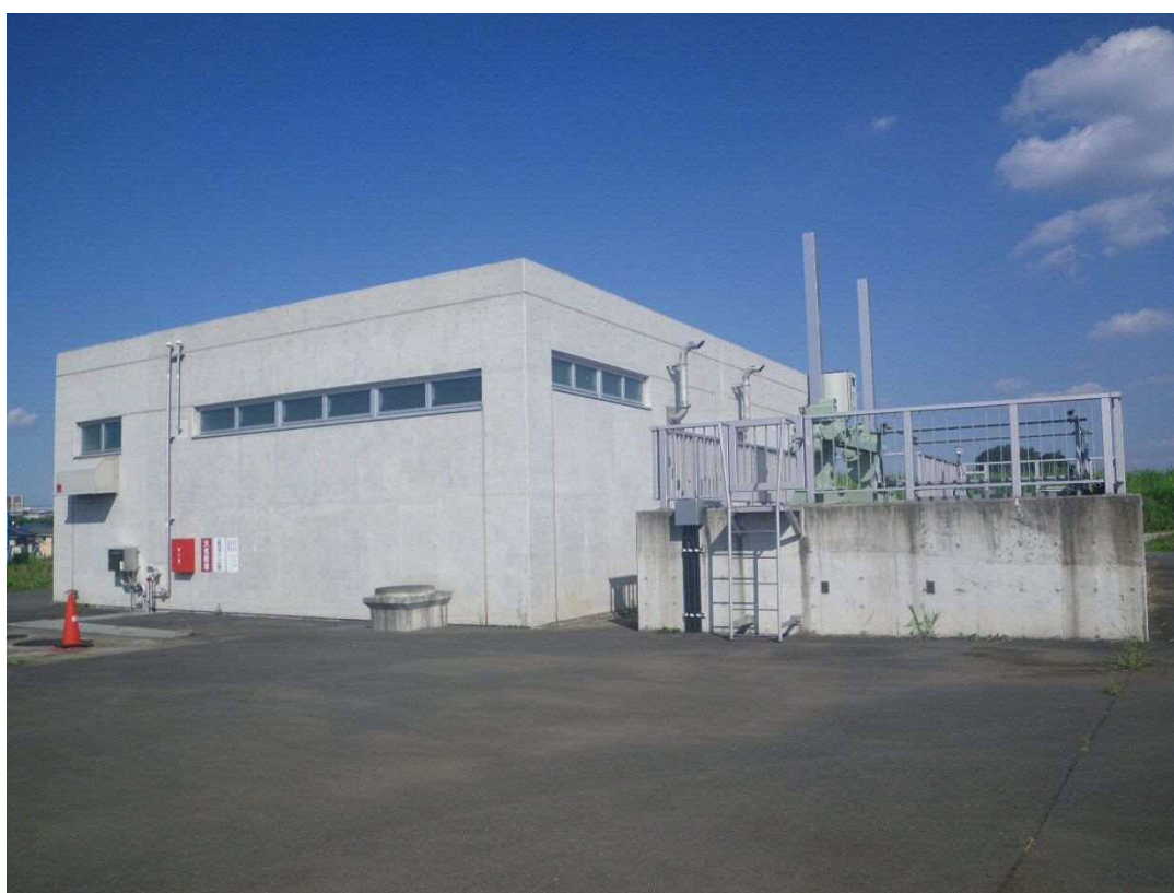
大間雨水ポンプ場
