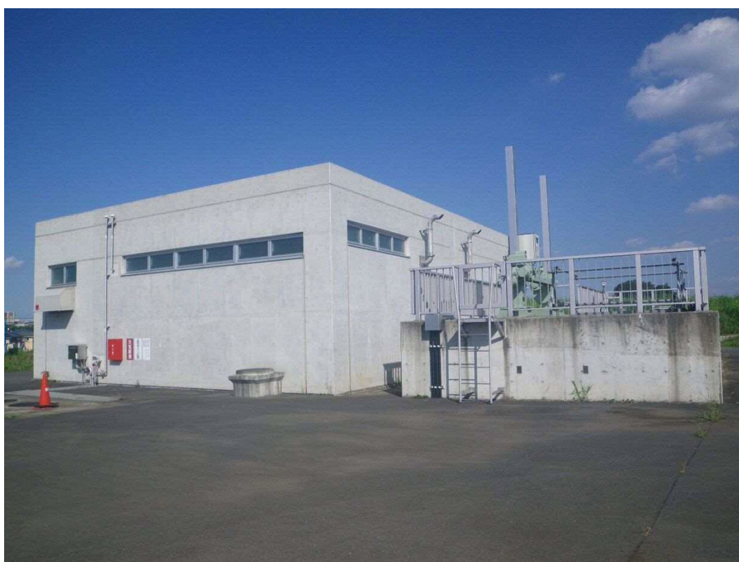
大間雨水ポンプ場
