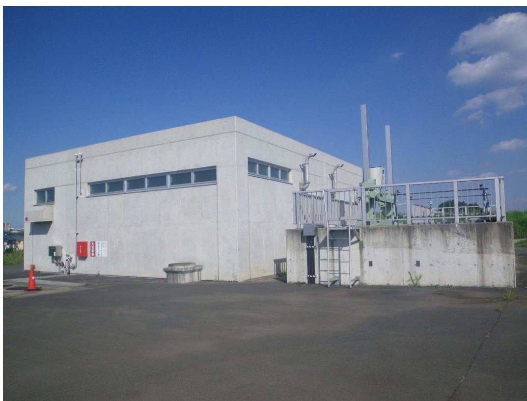
大間雨水ポンプ場
