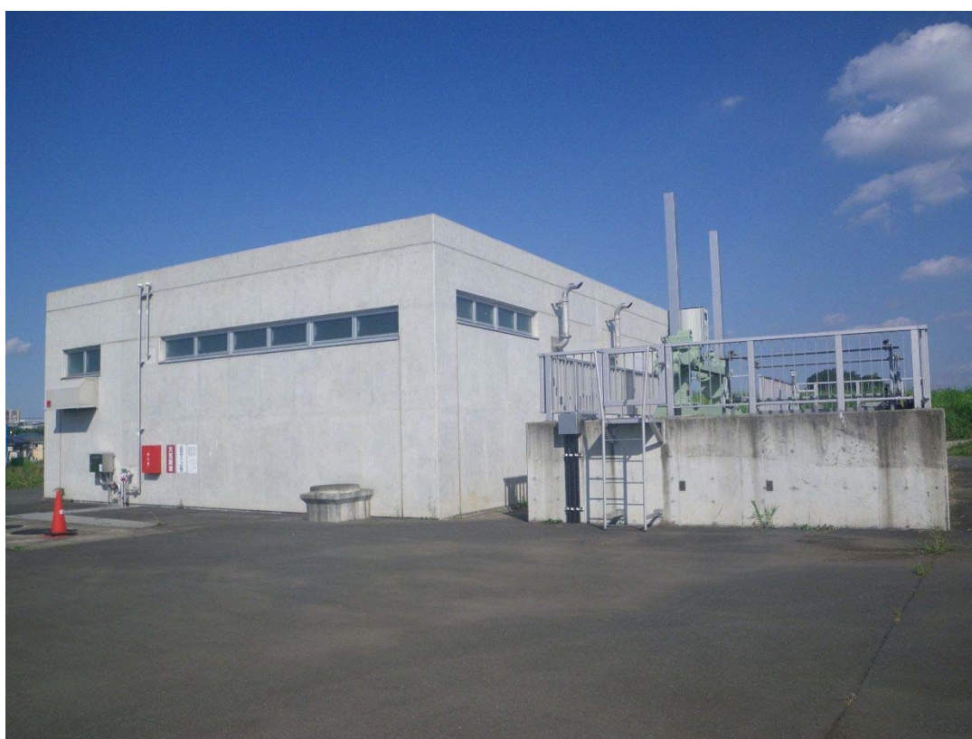
大間雨水ポンプ場
