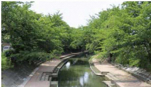
吹上元荒川親水護岸
