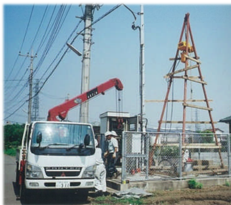
井戸改修の様子
