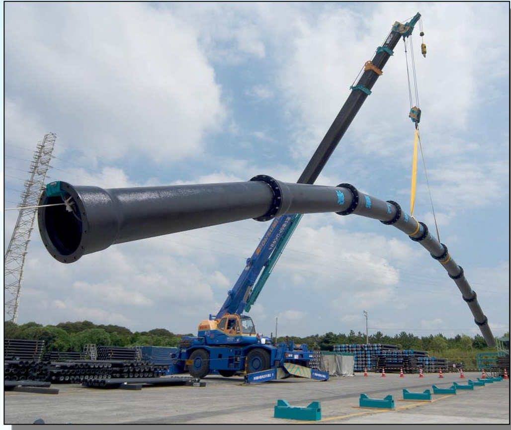
管路の吊上げ状況例
