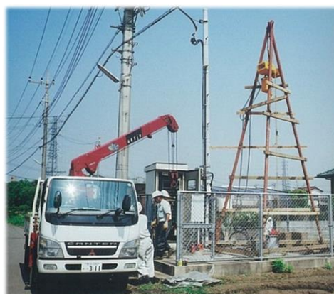
井戸改修の様子
