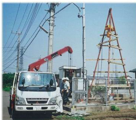
井戸改修の様子
