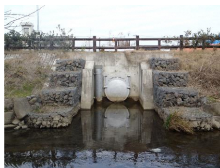
5号調整池吐口 (北新宿第二土地区画整理事業地内)
