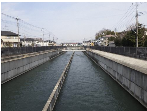
武蔵水路 (中宿橋近辺)
