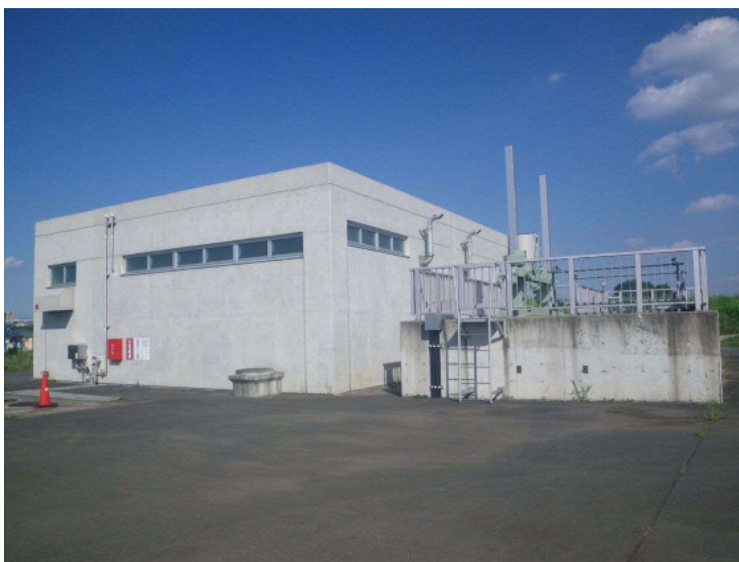
大間雨水ポンプ場
