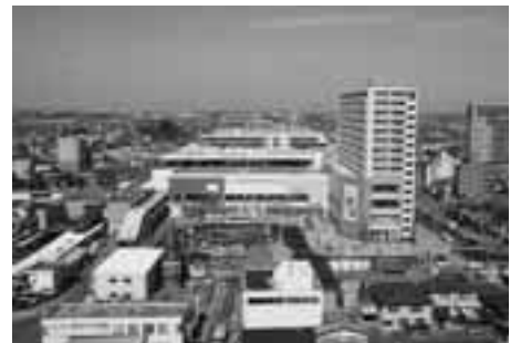
南側からの全景
